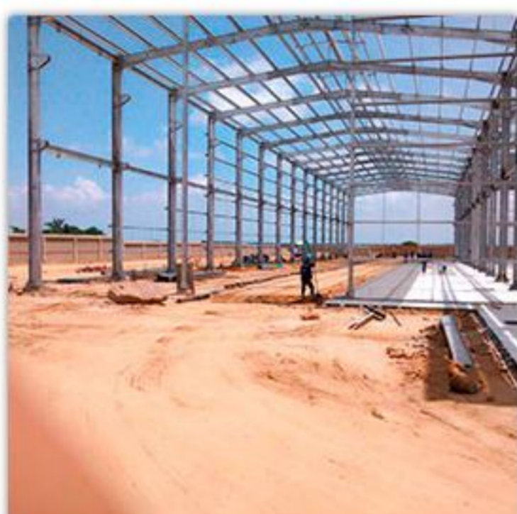
Fabricación de Estructuras Metálicas
