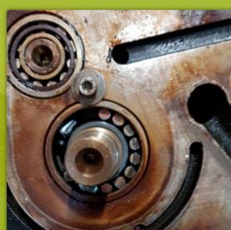
Verificación de Fallas en Equipos Rotativos
